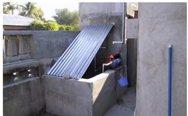
Unser Brunnen vor dem Haus, aus dem wir mehrmals am Tag Wasser hochziehen und in Kesseln ins Haus tragen.
